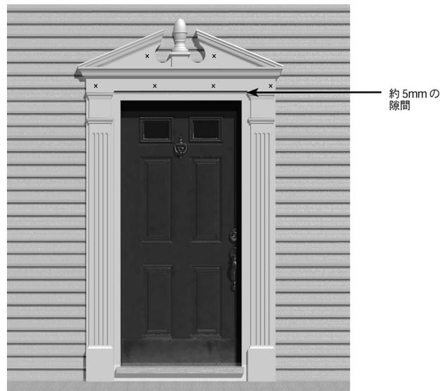
ヒント：サイディングの上にクロスヘッドを取付ける場合には、ネジの使用をお勧めします。PLプレミアム接着剤に加えて、ネジを併用することによりしっかりと固定することができます。
